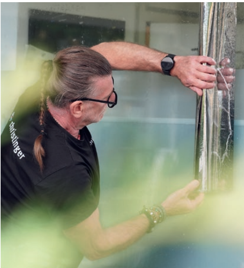
Montage von Sonnenschutzfolie bei einem Kundenprojekt.
